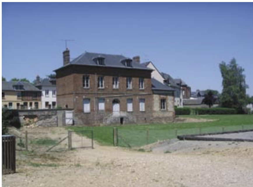
Presbytère avant le commencement des travaux
