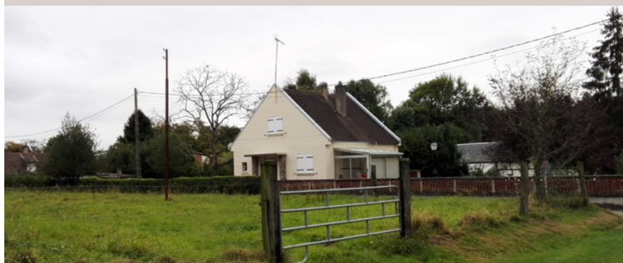
L'impact visuel de la construction est accentué par l'absence de végétation.
