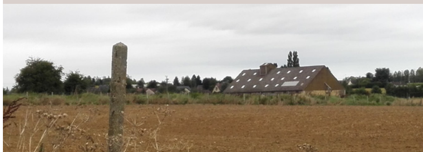
Le toit et les façades se déclinant dans des camaïeux de bruns facilitent l'intégration du bâtiment agricole malgré son volume imposant. En revanche, la multiplicité des fenêtres de toit gêne cet effet, apparaissant comme autant de tâches blanches dans le paysage.
