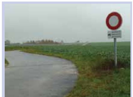
Rétrocession de l'Etat à la Commune de la voie en parallèle de la RN, voie ouverte aux engins agricoles et aux cyclomotoristes.
