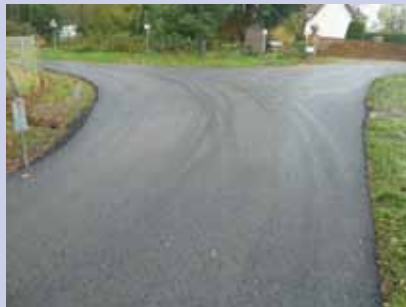
Réfection du Carrefour de l'Entre deux Landes et de la rue de la Grande Vente
