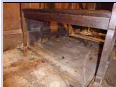
En cours : démontage avant réfection des planchers de l'église dans le transept
