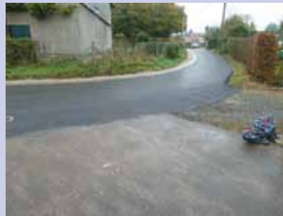
Réfection du virage de la rue du Richebourg
